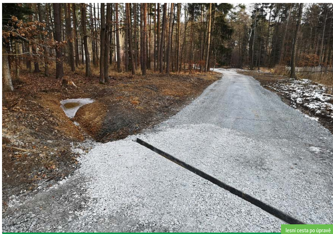
úprava lesní cesty
