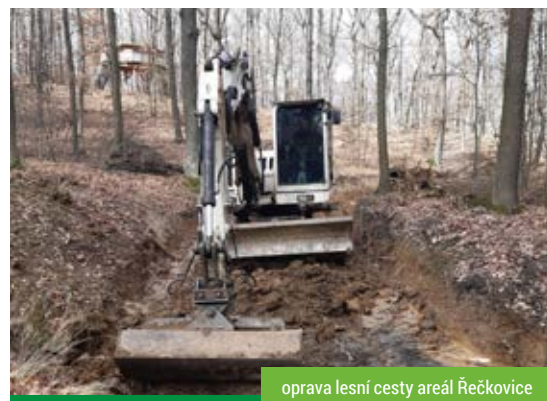
oprava lesní cesty areál Řečkovice
