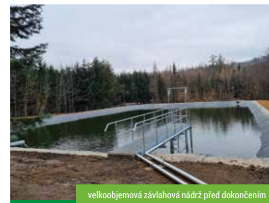
výstavba nové závlahové nádrže
